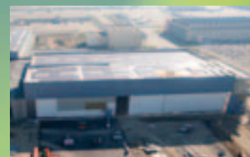
Toit du nouveau bâtiment de la ligne d'assemblage final A350 constitué de 22 000 m 2 de panneaux solaires.
